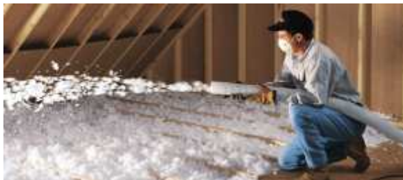
Figure 18: illustration du soufflage de laines minérales (Johns Manville company 2008)
