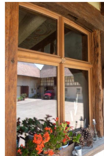
*Pose de nouvelles menuiseries en bois avec double vitrage (67)*
