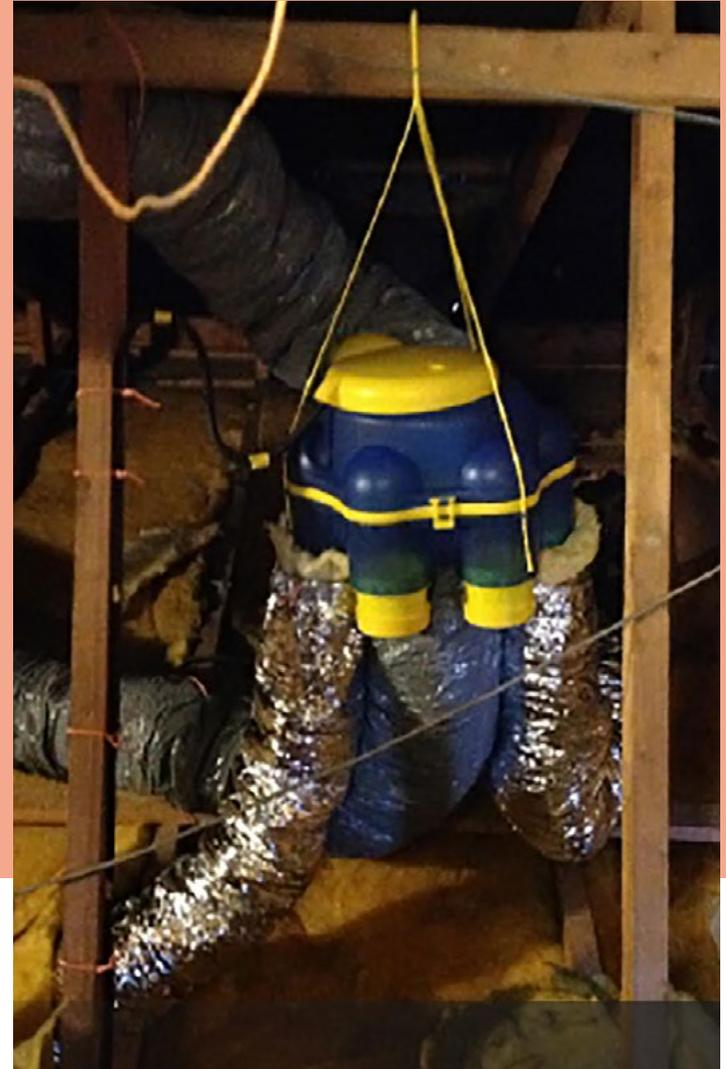
*VMC simple flux installée dans des combles perdus*
