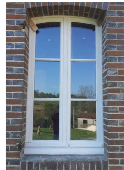
*Pose de nouvelles menuiseries en bois avec double vitrage (89)*
