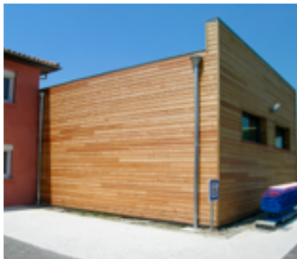
La mise en œuvre d'un sol absorbant (ici une zone basse avec des gravillons) permet d'éviter les discolorations dues aux eaux de rebond. Biocoop de Quint Fonsegrives (31) - 2008 - Architecte Marie-Christine Couthenx
