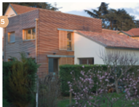
Pose à recouvrement horizontal, dite à clin
