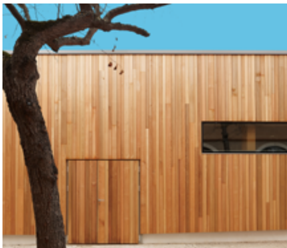
Différence de teinte du bois sans finition (à gauche en 2011 et à droite en 2016) Salle polyvalente « Le préau couvert » à Villeneuve-Tolosane (31) - Architecte Rendez-Vous (Isabelle Paoli)
