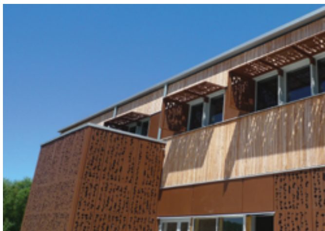
Acier Corten en mixité avec un bardage en mélèze sur un magasin Gamm Vert à Lacapelle-Marival (46) - Agence PhBa - 2013
