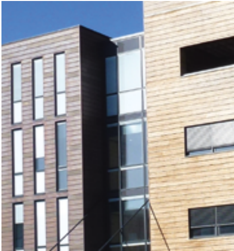
Mixité bardage cuivre et bois sur les locaux de MIPH en mixité bois et béton à Toulouse (31) - Agence Vigneu et Zilio - 2012
