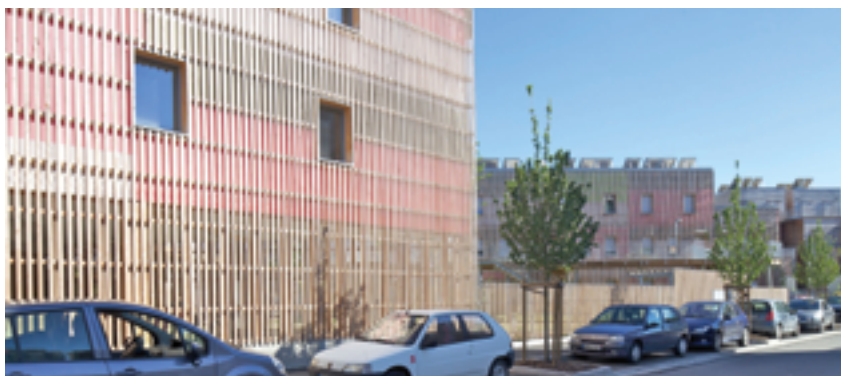
Îlot Bois Soleil à Toulouse (31) - Architecte : Transform et 109 Architectes - ©Philippe Ruault
