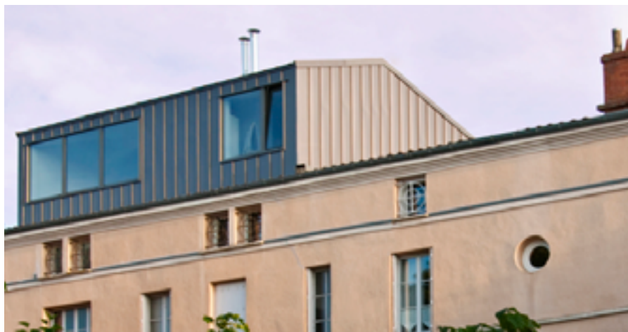
Bardage en acier à joints debout pour une surélévation à Toulouse (31) - Architecte : AR-QUO - 2014
