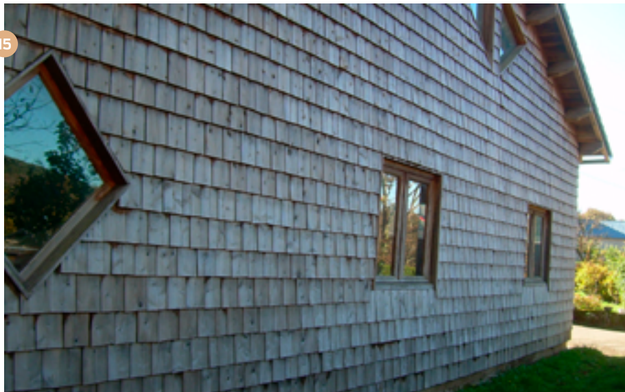
15 - Maison individuelle couverte de tavaillons en mélèze ©Scierie Mobile du Haut Languedoc
