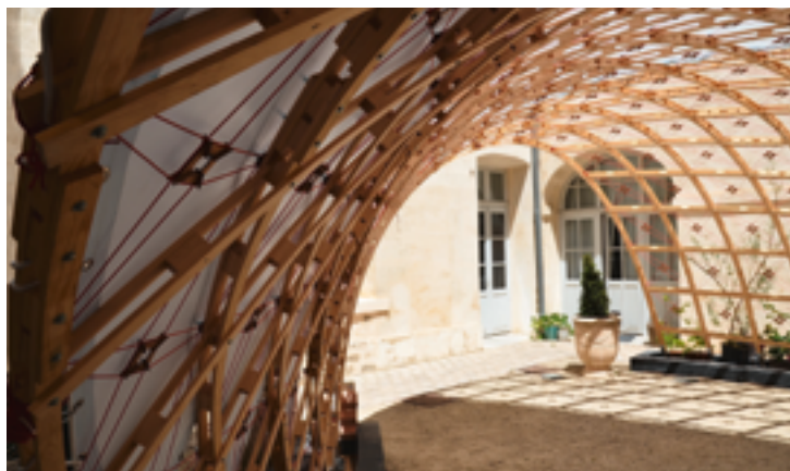
Gridshell à Montpellier (34) - 2016 - Entreprise Quaternion
