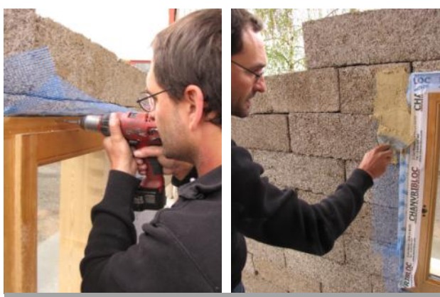
8. Fixation de la fenêtre sur le pré-cadre et marouffage de la partie tramée du frein vapeur dans l'enduit.
