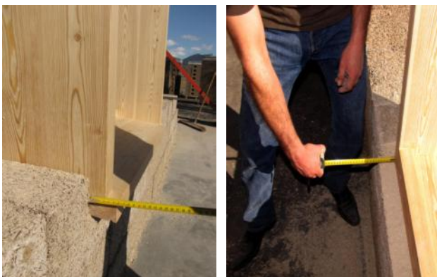
3. Placement du pré-cadre. Celui-ci doit dépasser de 3 cm en extérieur et de 1 cm en intérieur une fois la fenêtre installée.
