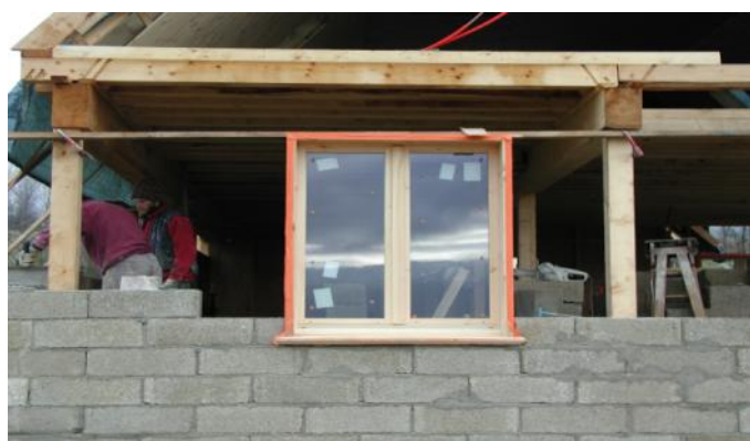
Mise en place d'un ensemble pré-cadre et menuiserie bois dans un mur en blocs de chanvre
