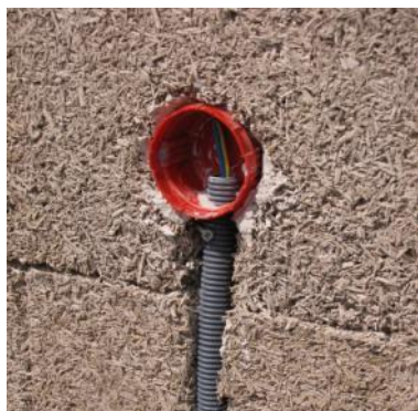
Boîtier et gaines placés dans le rainurage
