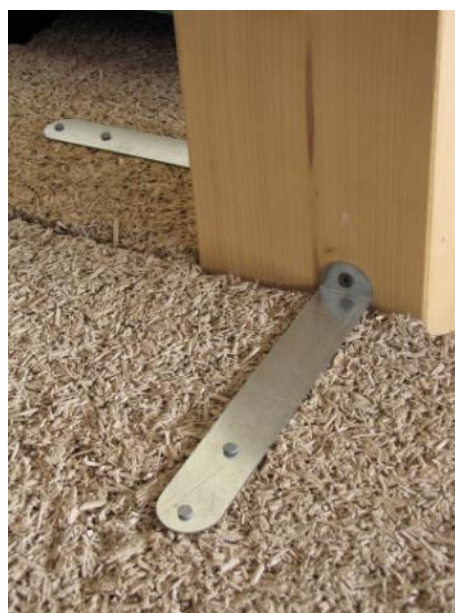
Liaison sur poteau-poutre
