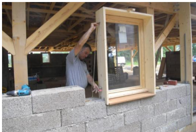
Mise en place d'un ensemble pré-cadre et menuiserie bois dans un mur en blocs de chanvre
