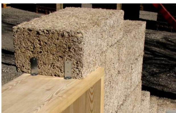
6. Fixation des blocs sur la partie haute du pré-cadre avec des petites équerres.
