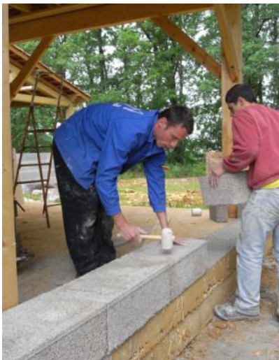
Ajustement des blocs au maillet
