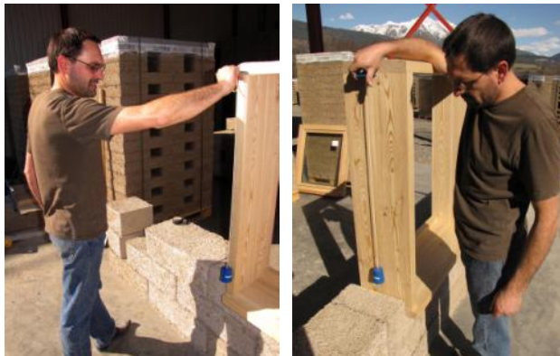
4. Vérification de l'aplomb du pré-cadre. Pour le caler avant la fixation des blocs, il est conseillé de le relier par un tasseau à une pièce de charpente.
