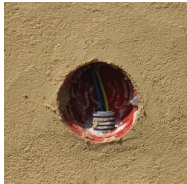
Boîtier après enduit
