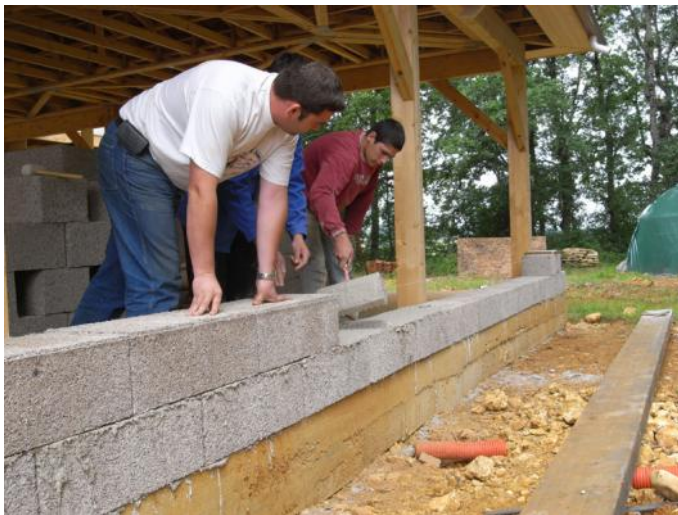
Pose du second rang sur joint mince
