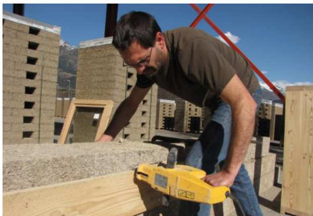
2. Coupe horizontale des blocs à la scie alligator.
