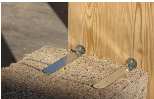
5. Fixation des blocs aux montants du pré-cadre. Les équerres sont fixés par une vis VBA 4x40 à la menuiserie et deux pointes galva 3x70 aux blocs.
