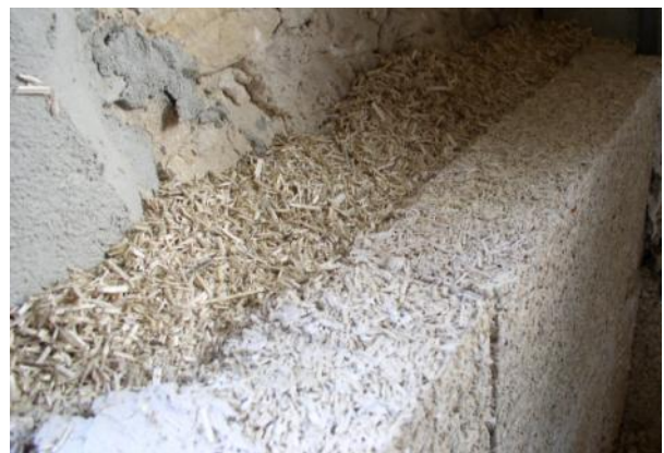
Remplissage de vide d'air avec chènevotte
