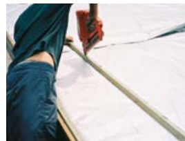
Contre-latter dans le sens de la pente. Pose par vis, pointes crantées ou torsadées
