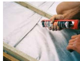
Mettre un cordon de colle P.U. pour l'étanchéité
