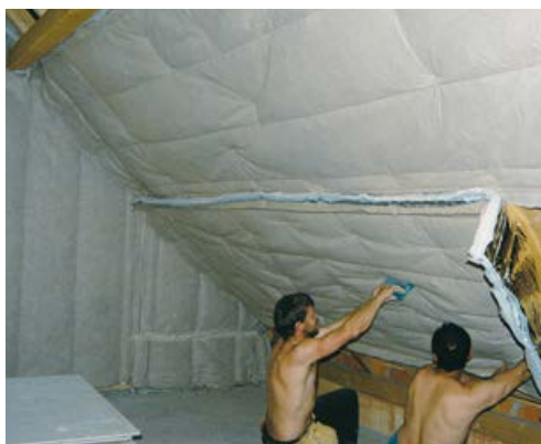
Agrafer sous chevrons, entre pannes. Assurer un recouvrement des lés de 5 cm. À la jonction des lés, fixer une lame de bois clouée ou vissée sous chevron pour l'étanchéité.
