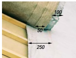
Assurer un recouvrement de 50 mm isolant sur isolant. L'écran est tracé pour repérer et faciliter le chevauchement des lés
