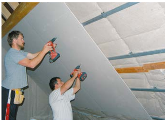
Poser la finition plaque de plâtre ou lambris sur un cadre de tasseaux 20 mm d'épaisseur.
