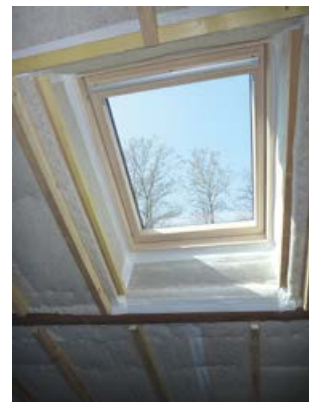
Parfaite isolation et étanchéité à l'air autour des fenêtres de toit
