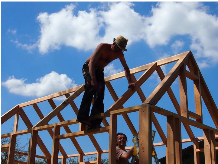
Photo 2 : structure d'une tiny house
