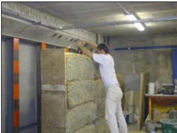
Figure 13 La planéité du mur laisse encore à désirer
