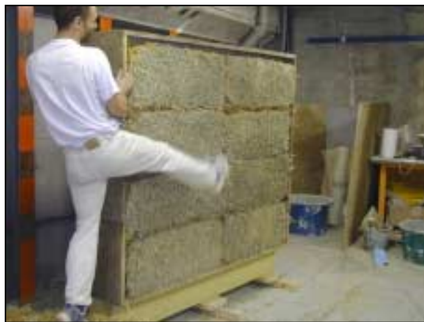
Figure 16 Vérification : la planéité est maintenant satisfaisante
