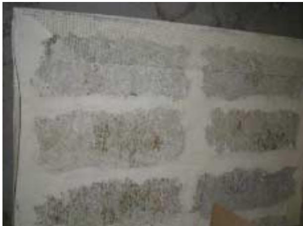
Figure 20 Mur paille avant enduits
