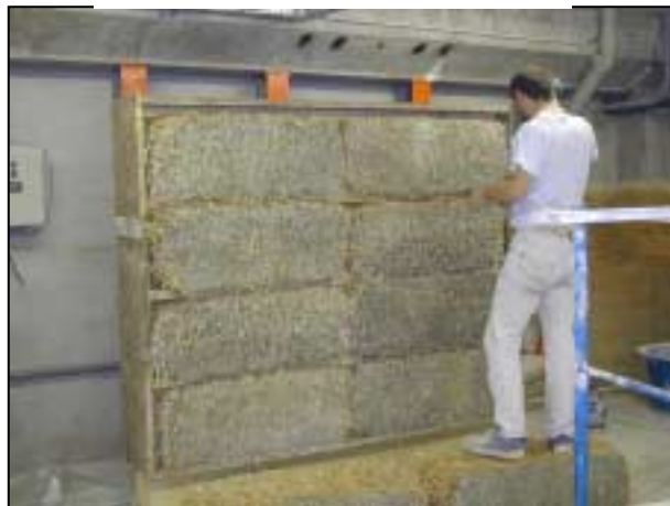
Figure 14 Rectification de la position des bottes
