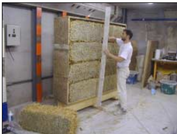
Figure 16 Vérification : la planéité est maintenant satisfaisante
