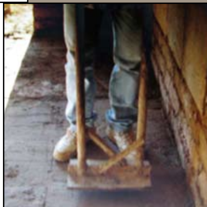
Un pisolier de grande dimension facilite la mise en oeuvre.
