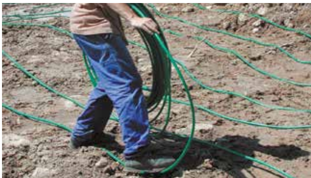
Pose de capteurs horizontaux.
