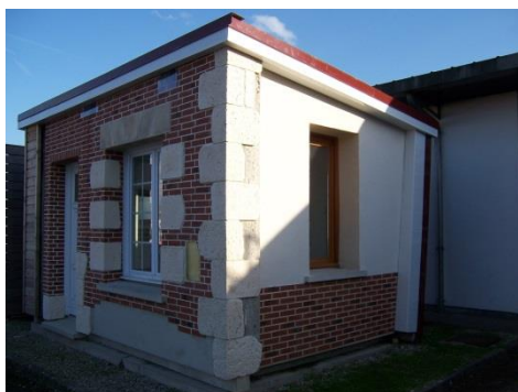
Exemple de parois préfabriquées en usine et assemblées sur site
